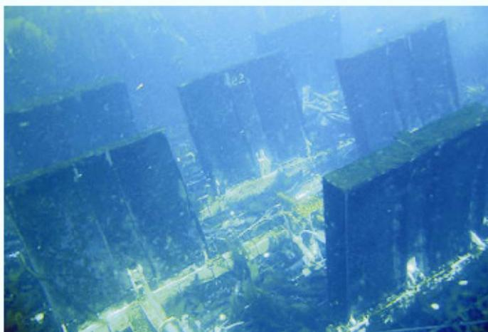
Abb. 22: Bei einem Wellenroller-Kraftwerk wird die kinetische Energie der Wellen über Platten auf eine Kolbenpumpe übertragen und anschließend ein Generator oder eine Turbine betrieben.
