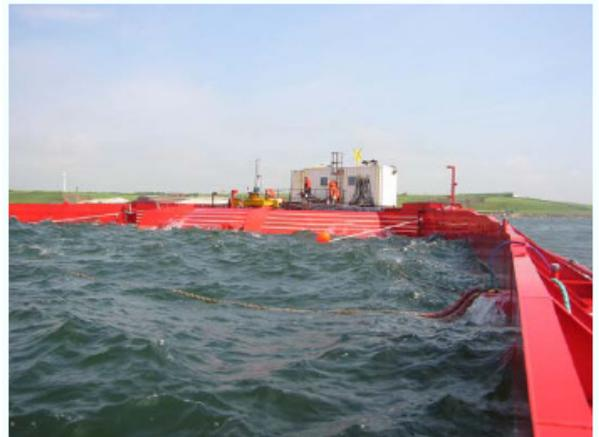
Abb. 29: Beim Wave Dragon werden die Wellen auf eine Rampe geleitet und füllen ein Bassin. Die potentielle Energie wird dann zur Energiegewinnung genutzt.
